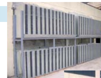
Instalación de Silenciadores de Entrada de Aire Sala.
