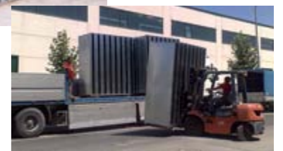
Suministro e instalación.
